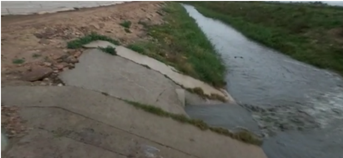
Foto 3. Aliviadero EDAR Torre Pacheco el día 3 de diciembre de 2019.
